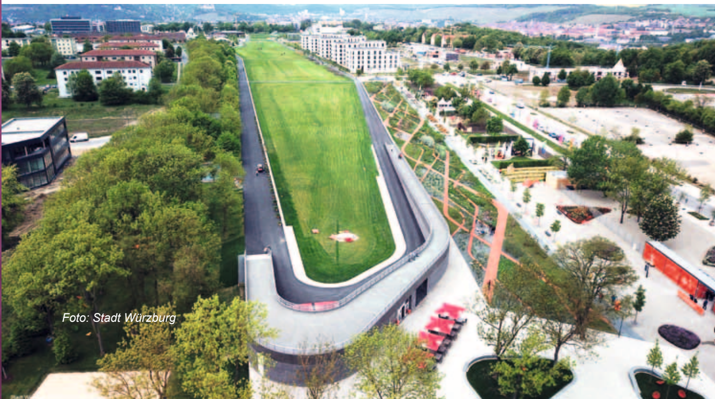
Blick über das Belvedere auf das LGS-Gelände mit flankierendem Wohnungsbau
