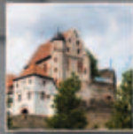
Blick auf die Burg Alzenau, Foto: Holger Leue
